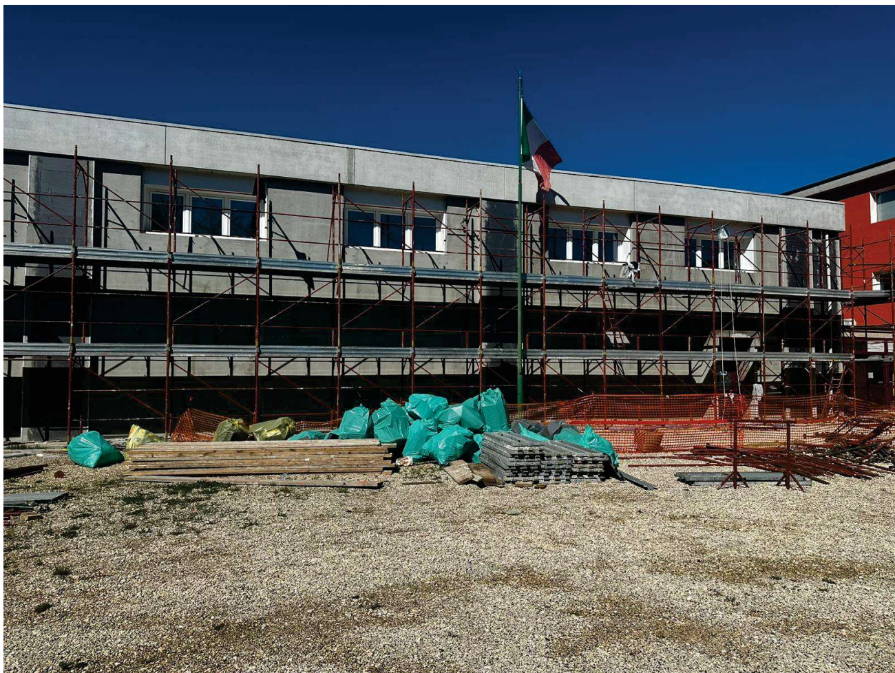
Vista della palestra durante i lavori di riqualificazione energetica
