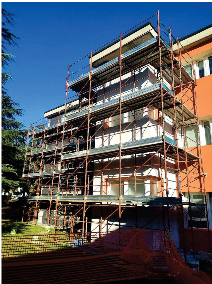
Vista dell'edificio scolastico con particolare sul volume che ospita i servizi igienici durante i lavori di riqualificazione energetica
