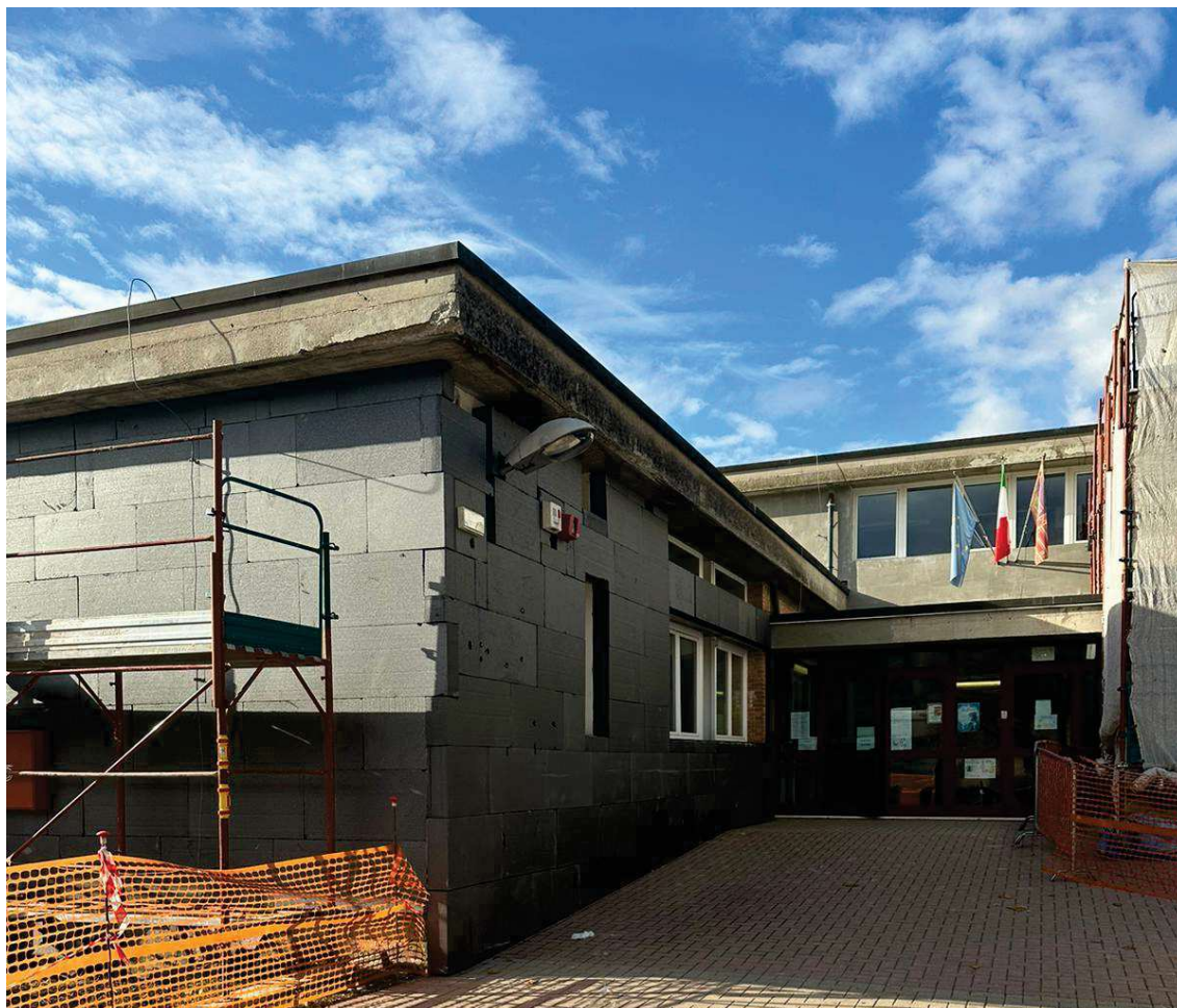
Vista dell'ingresso all'edificio durante l'esecuzione dei lavori di riqualificazione energetica
