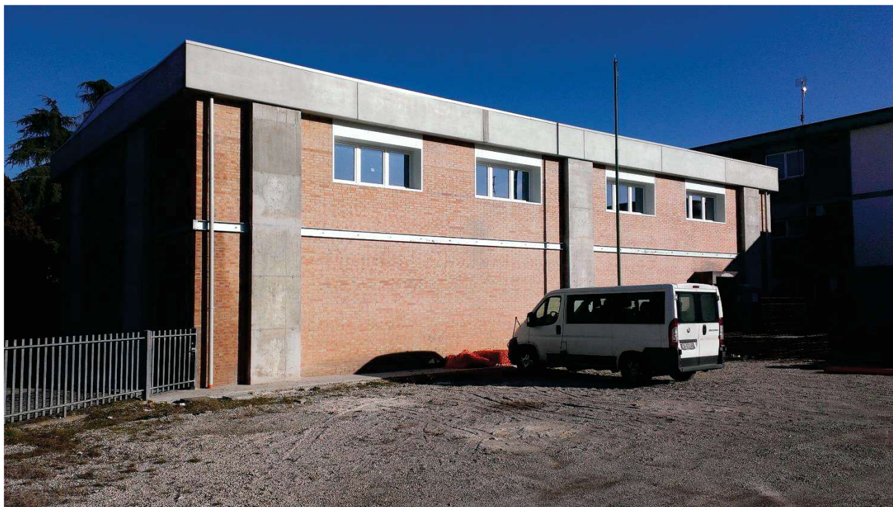
Vista della palestra prima dell'intervento di riqualificazione energetica
