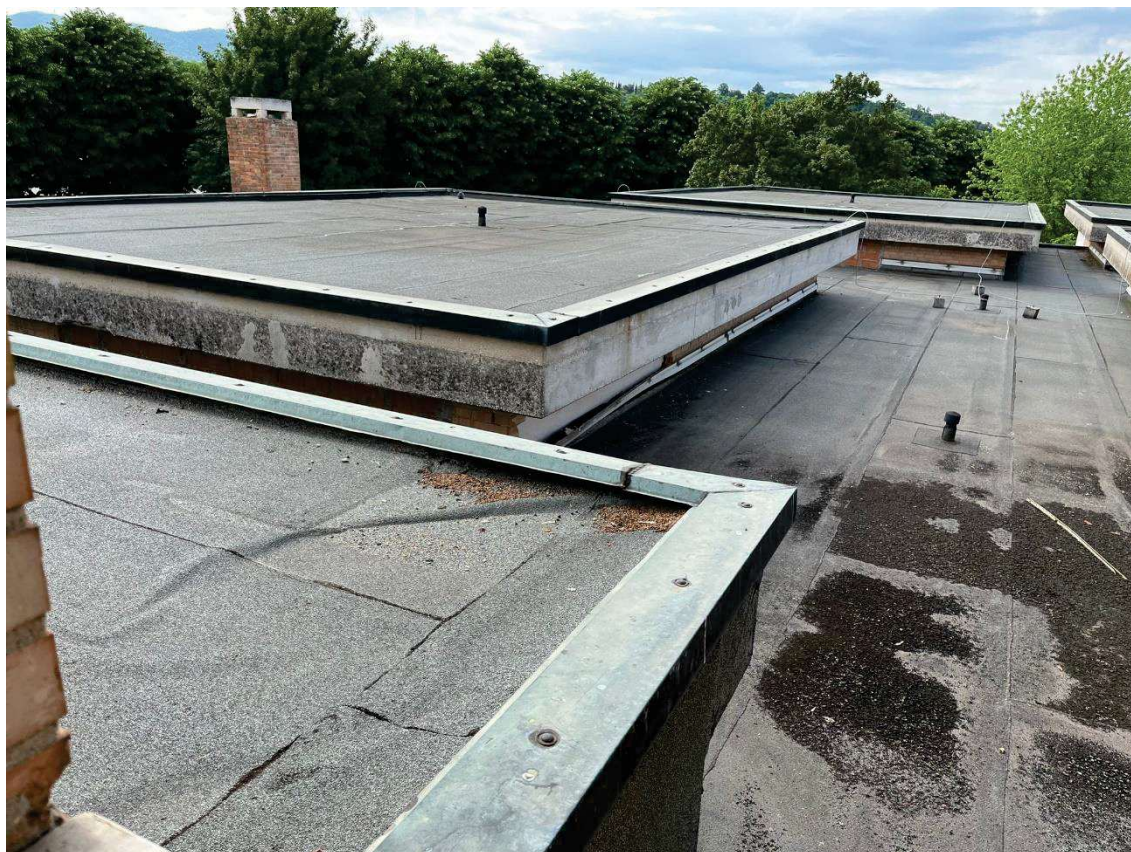
Vista della copertura prima dell'intervento di riqualificazione energetica.
