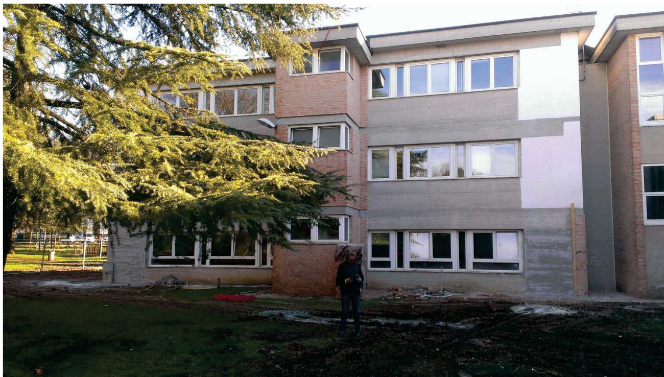
Vista del cortile retrostante dell'edificio scolastico prima dell'intervento di riqualificazione energetica
