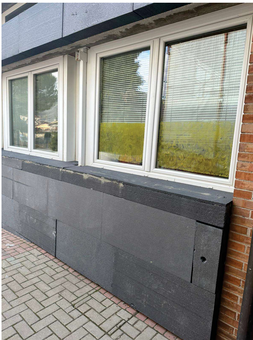
Vista di dettaglio in fase di esecuzione sul raccordo parete-aperture
