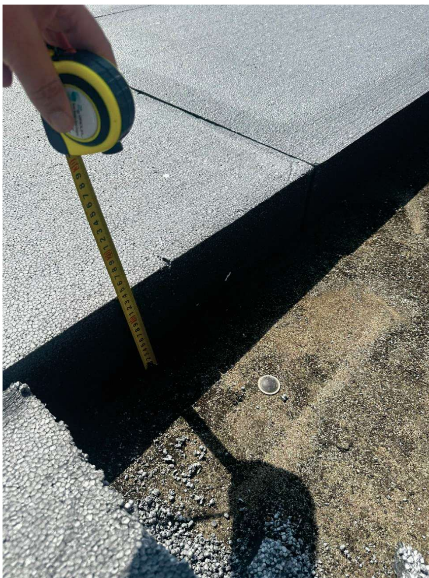
Viste di dettaglio con metro di riferimento per accertamento dello spessore.
