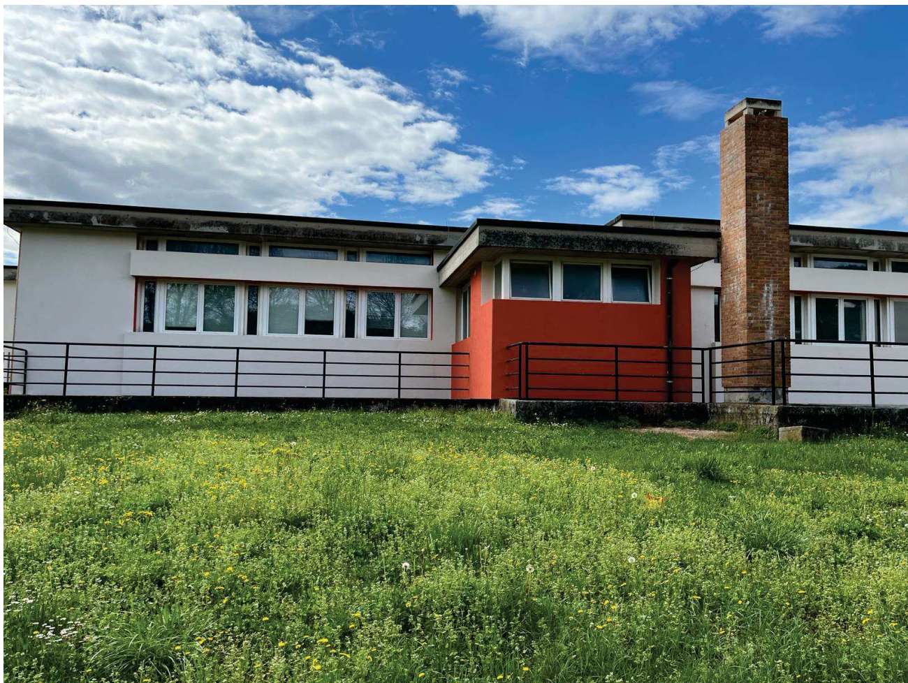
Vista dell'edificio scolastico su Via Del Donatore a lavori ultimati.
